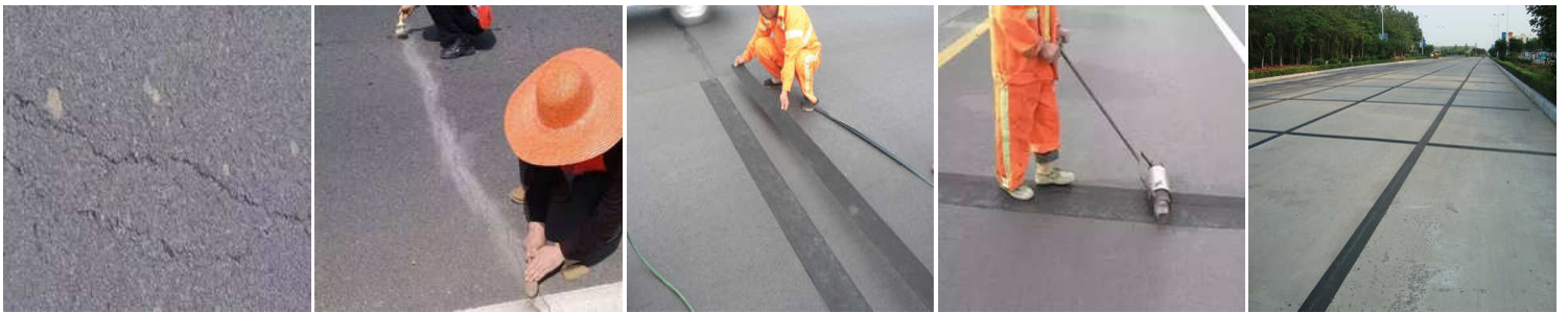
1. ทำความสะอาดพื้นผิว 2. ปิดเทปซ่อมถนน 3. กลิ้งลูกกลิ้งให้เรียบแน่น 4. ใช้งานได้ทันที
