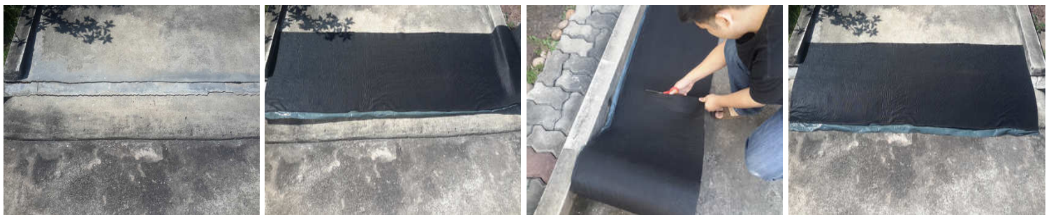
1.เตรียมพื้นผิวให้สะอาดและแห้ง 2.วางจัดเทปด้านพลาสติกลงเพื่อตัด 3.ตัดด้วยกรรไกรทั่วไป 4.จัดวางแผ่นเทปตามต้องการ
